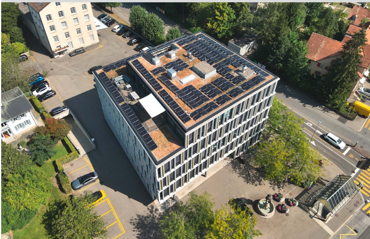
PV Anlage Blutspendezentrum
